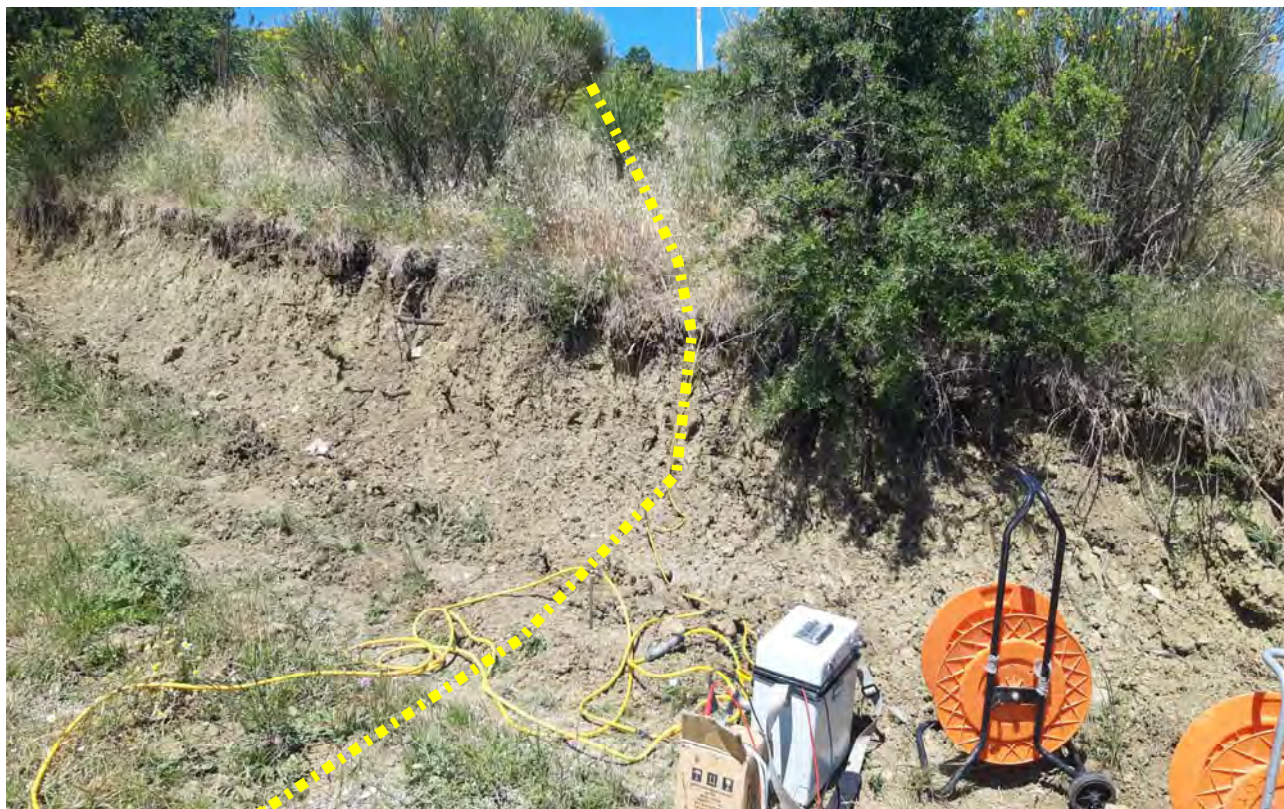
Area di Intervento "I" - Postazione Rilievo Geoelettrico Tomografico TE5 (vista W)
